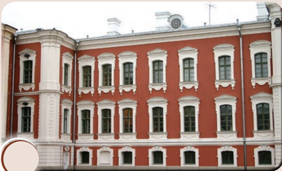
Atjaunotā Pils Ziemeļu korpusa fasāde
